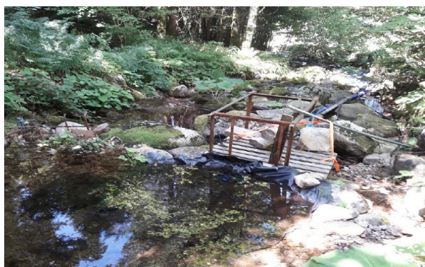
Prise d'eau artisanale barrant intégralement le cours d'eau
