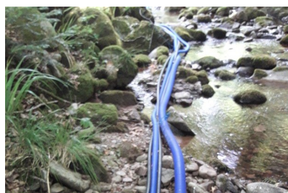
Les tuyaux d'alimentation vers le nouveau plan d'eau
