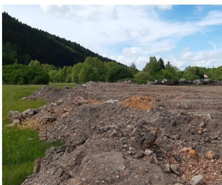
Remblais. Vue générale
